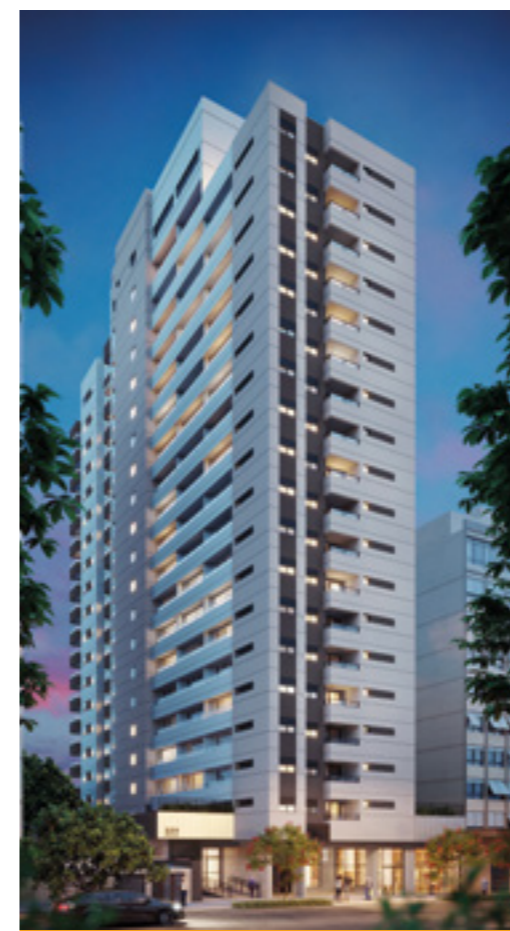
TODAY CENTRO - EM OBRAS
