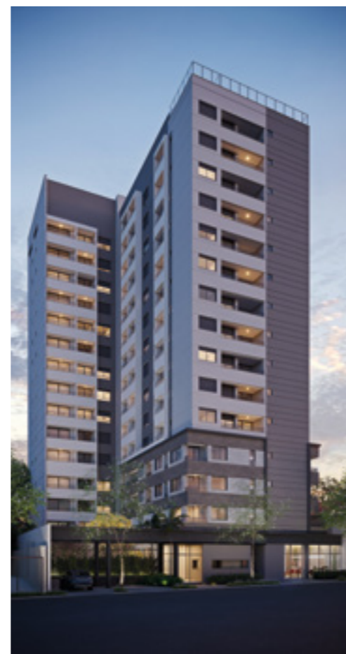
TODAY VILA MARIANA - EM OBRAS
