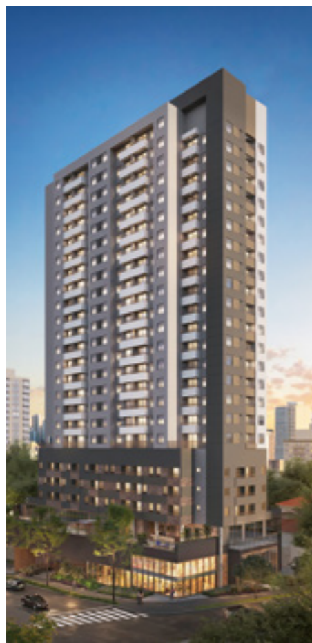
TODAY PERDIZES - EM OBRAS
