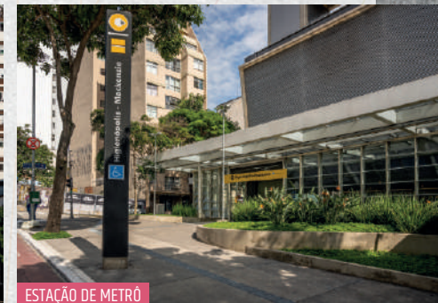
ESTAÇÃO DE METRÔ
