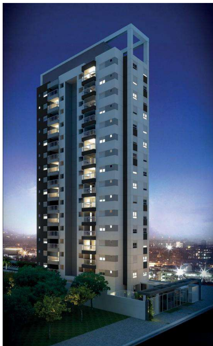
Praça Nami Jafet, 44 - Ipiranga Edifício Advanced Ipiranga
