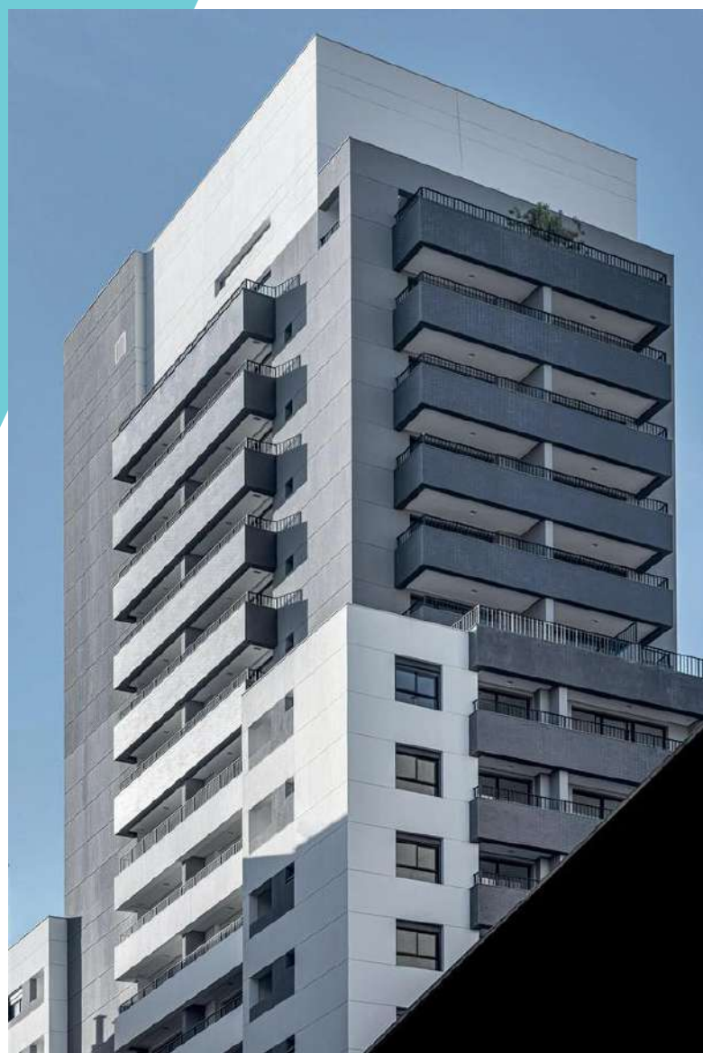
Rua Genebra, 296 - Bela Vista Edifício My Space
