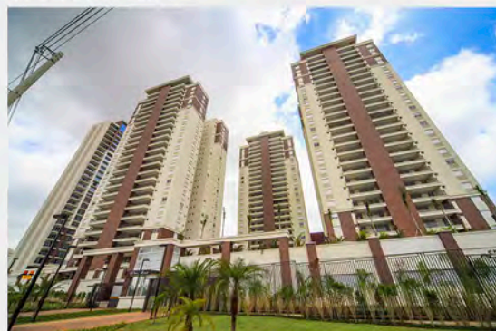
Residencial Casa das Caldeiras - São Paulo
