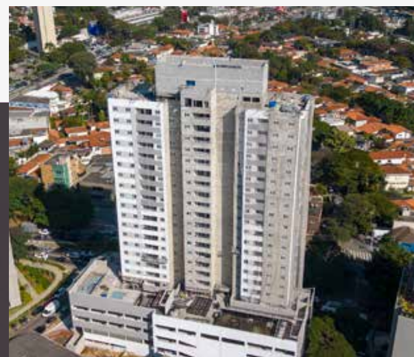
VIEW BUTANTÃ | FOTO DA OBRA - AGO/23
