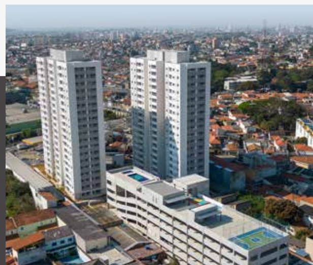
CITY PENHA | FOTO DA OBRA - AGO/23
