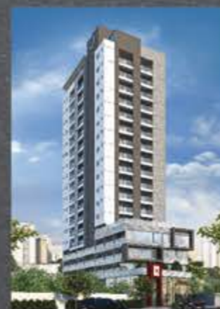
VIA MONTEIRO CONCLUÍDO
