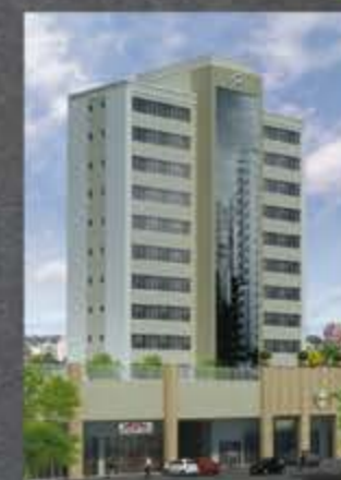
EDÍFICIO PLATINUM CONCLUÍDO
