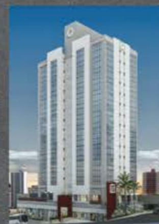
MONTEIRO CORPORATE CENTER CONCLUÍDO
