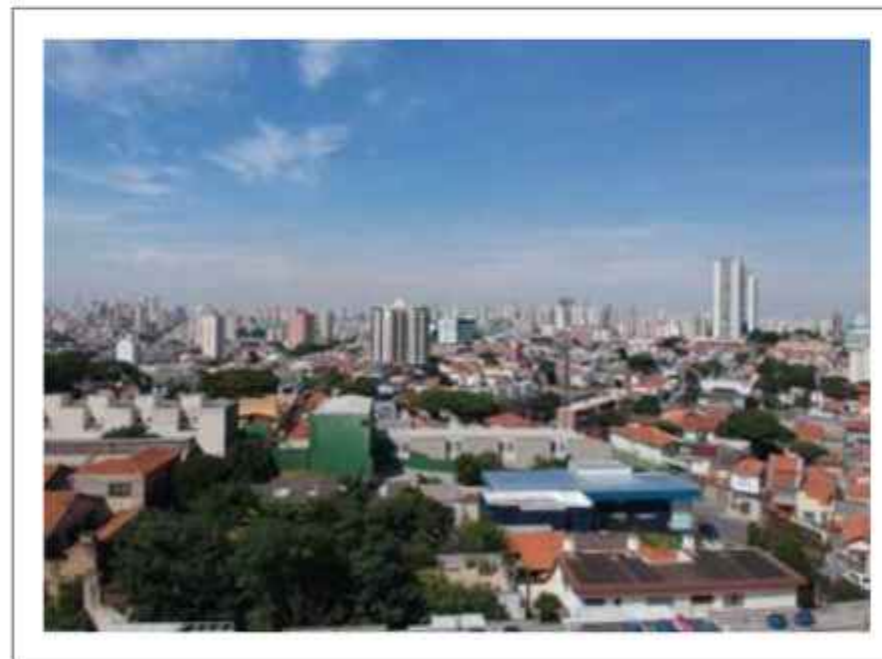
IMAGEM FOTOGRÁFICA FACE OESTE
