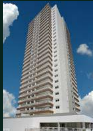
Metropolitan Vila Prudente Rua Imbituba, 154 Vila Prudente
