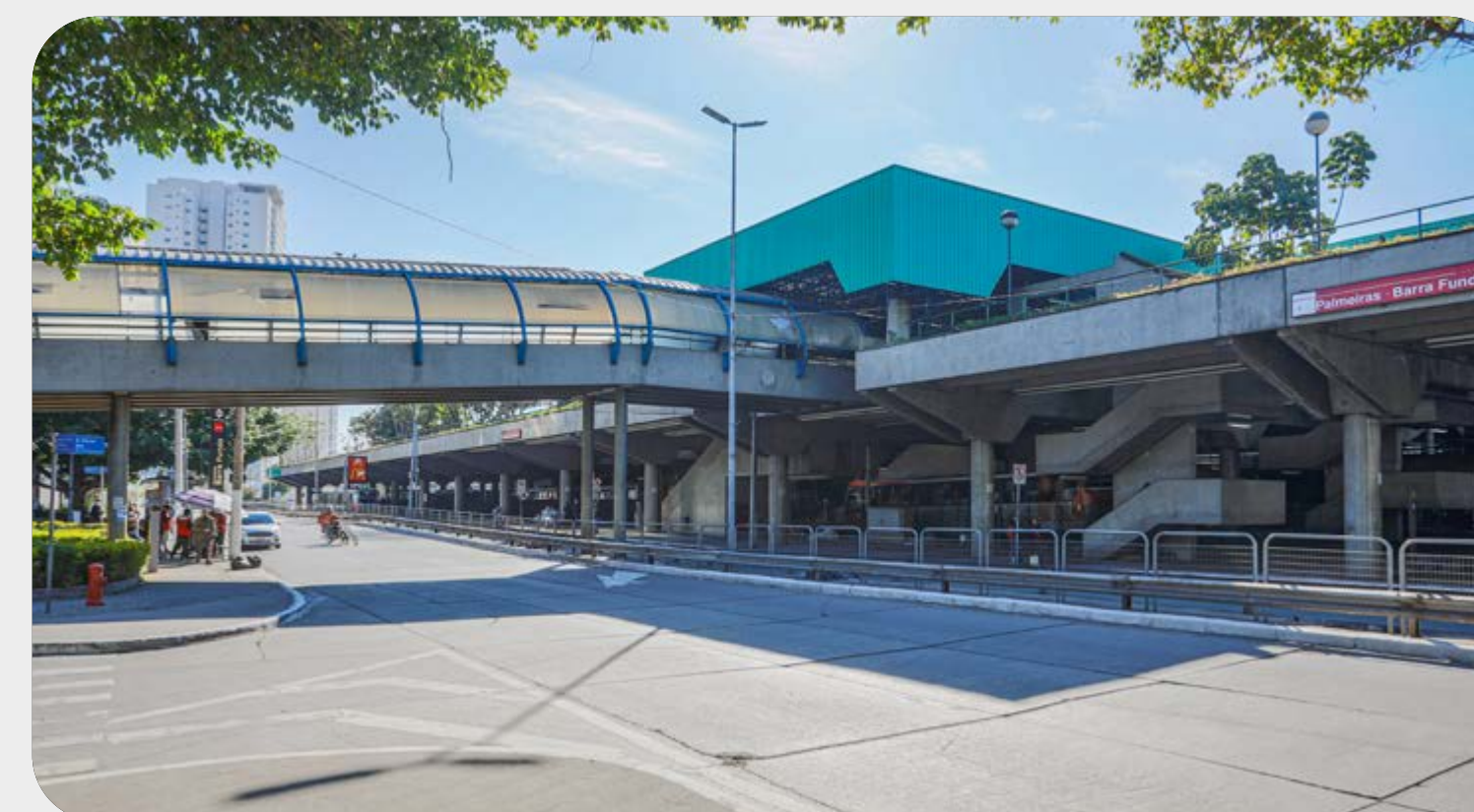
A 5 minutos da Estação Barra Funda
