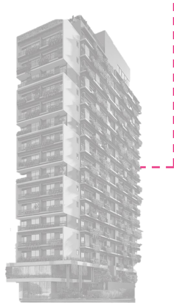
1º AO 10º PAVIMENTO (FACHADA POSTERIOR)
