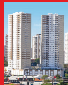
Condomínio Class Guarulhos
