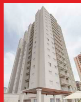
Edifício You, Penha
