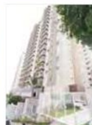
Edifício You Casa Verde
