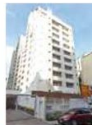
Edifício Sarmos Paulista
