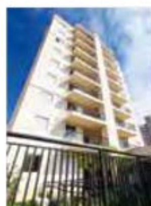
Edifício Ouro Ipiranga
