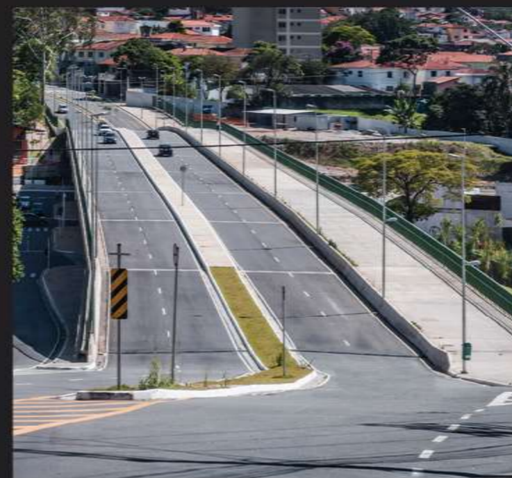
VIADUTO DA AV. DR. LINO DE MORAES LEME
