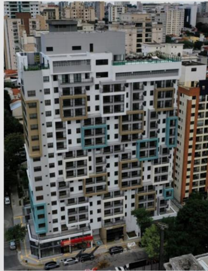
FOTO DA FACHADA DO NEX ONE MINISTRO FERREIRA ALVES
