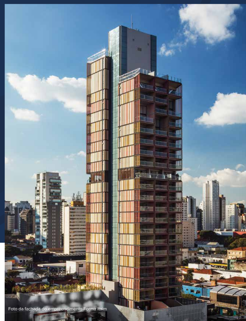
Foto da fachada do empreendimento Huma Klabin
