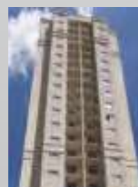
Edifício Connect Sacomã
