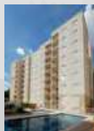
Edifício You Marajoara
