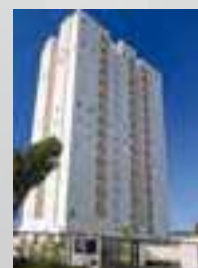
Edifício Felice Vila Formosa
