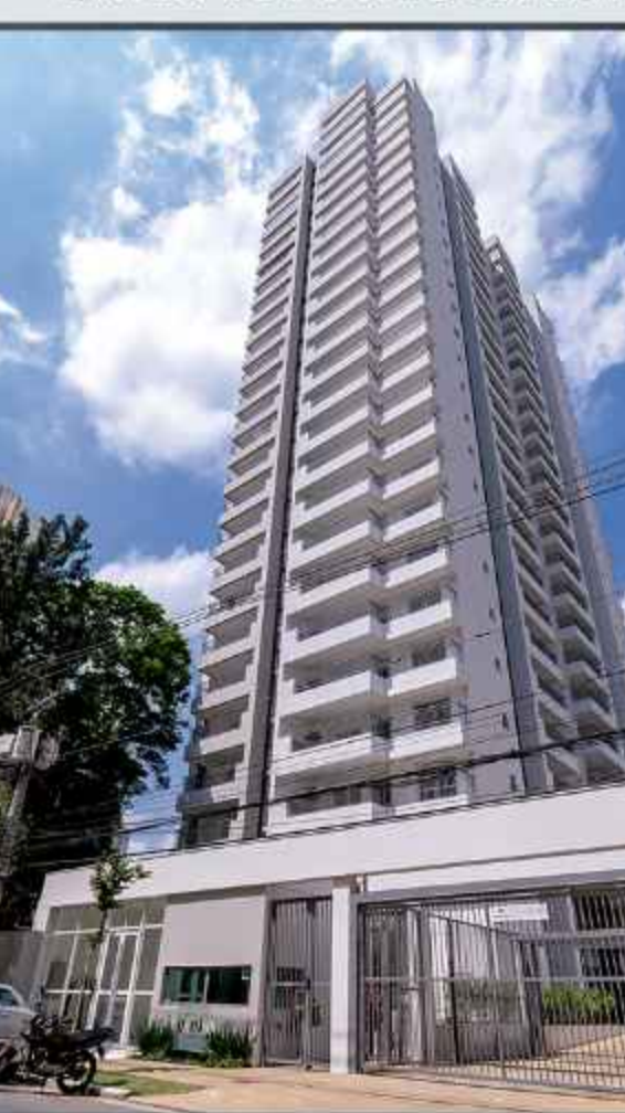
RUA DAS FLECHAS, 649
