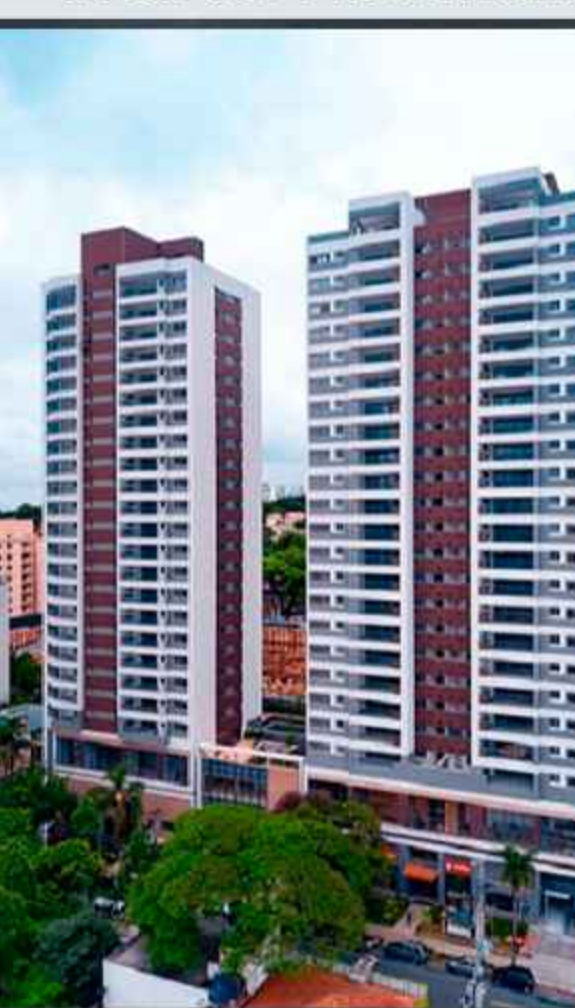
RUA DAS FLECHAS, 484
