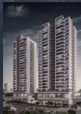
HIGH JD. PRUDÊNCIA RUA DAS FLECHAS, 484
