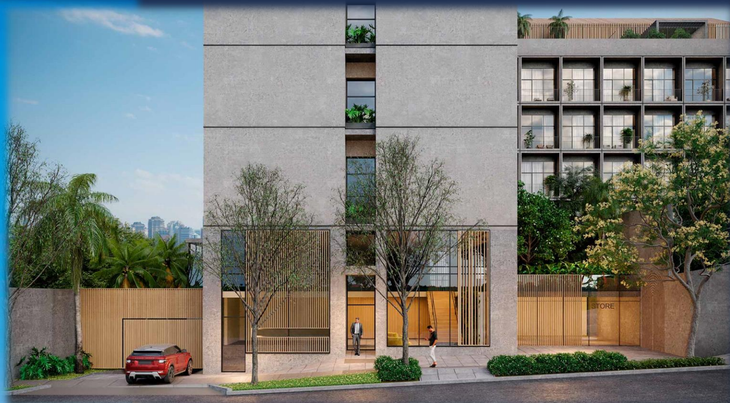
ACESSO RUA AIMBERÊ
