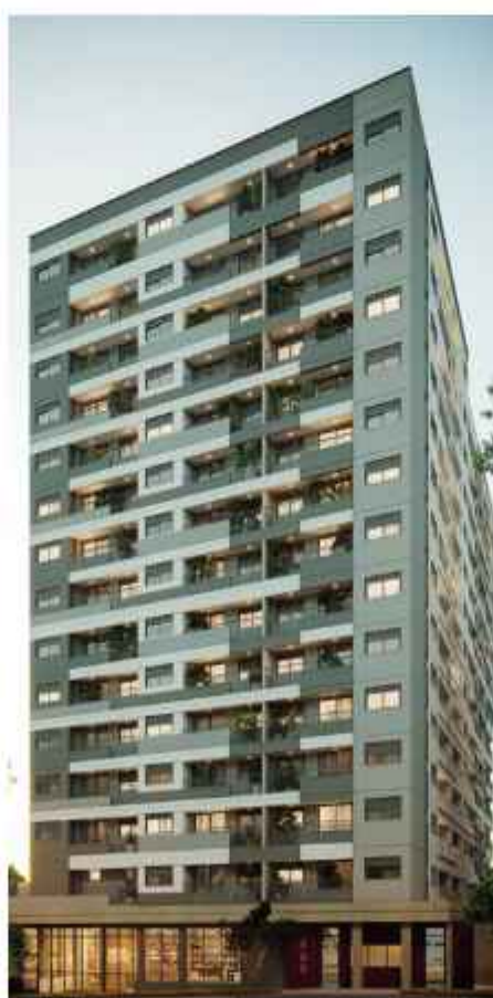
TODAY POMPEIA - EM OBRAS
