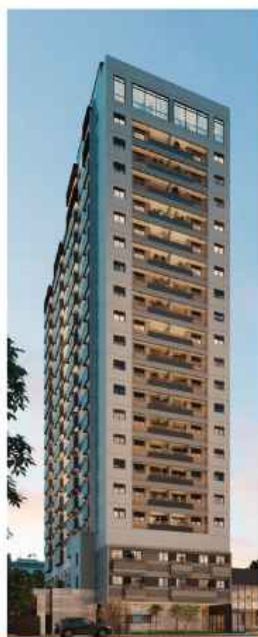
TODAY VILA OLÍMPIA - EM OBRAS
