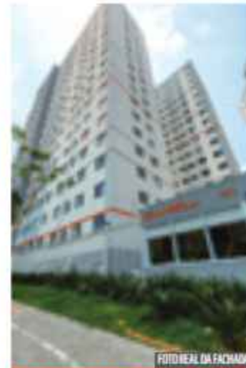
Vibra Estação Capão Redondo
