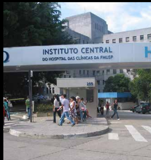
HOSPITAL DAS CLÍNICAS
