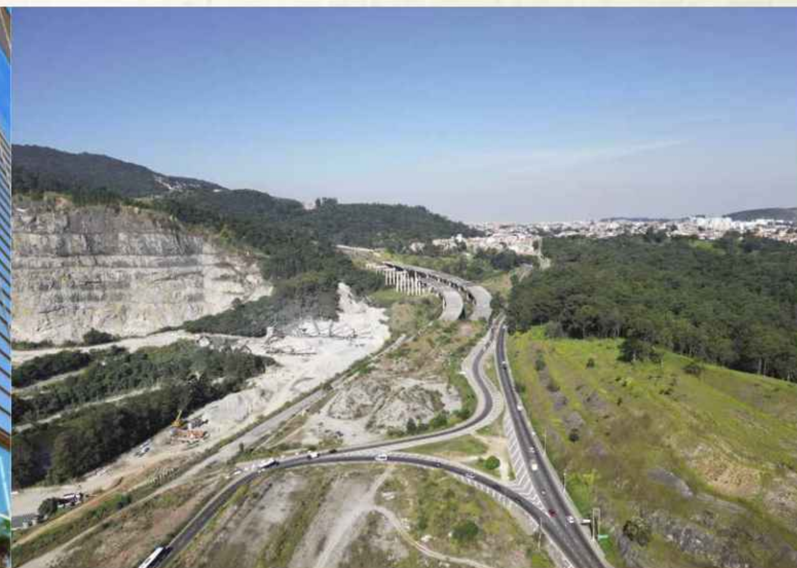
Obras do trecho norte do Rodoanel
