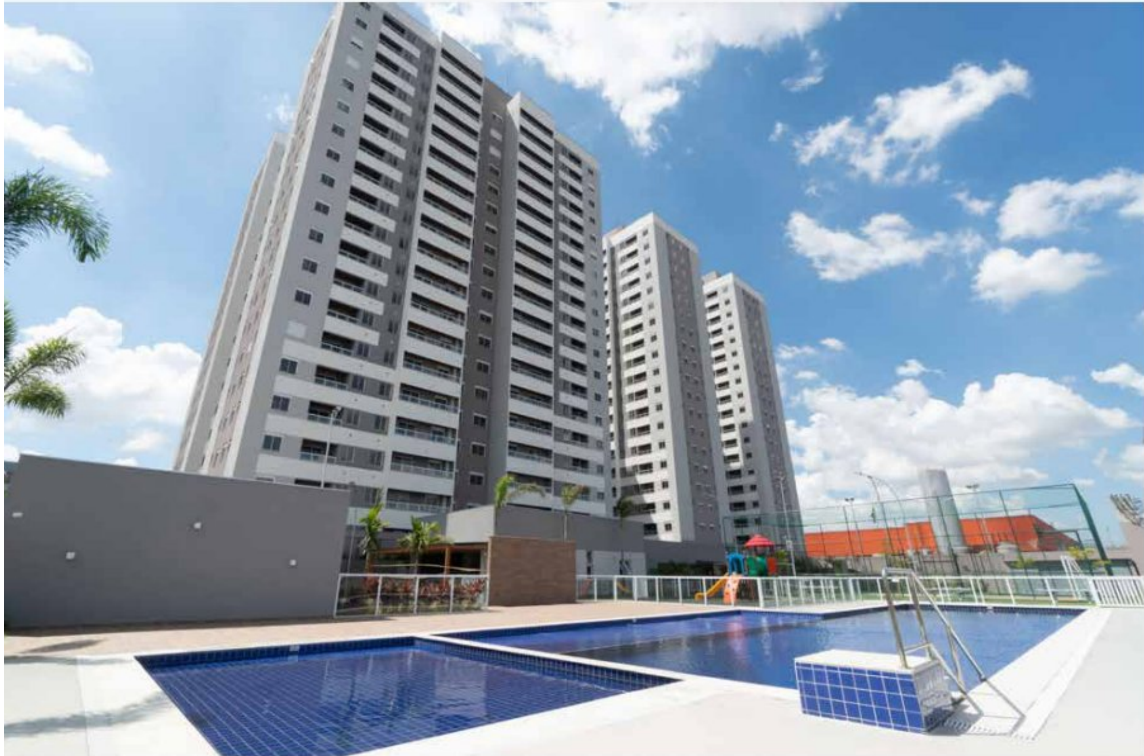
AVENIDA DOS ESTADOS - SANTO ANDRÉ/SP
