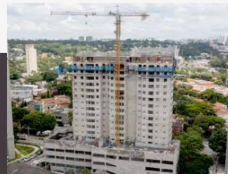
VIEW BUTANTÁ | FOTO DA OBRA - FEV/23
