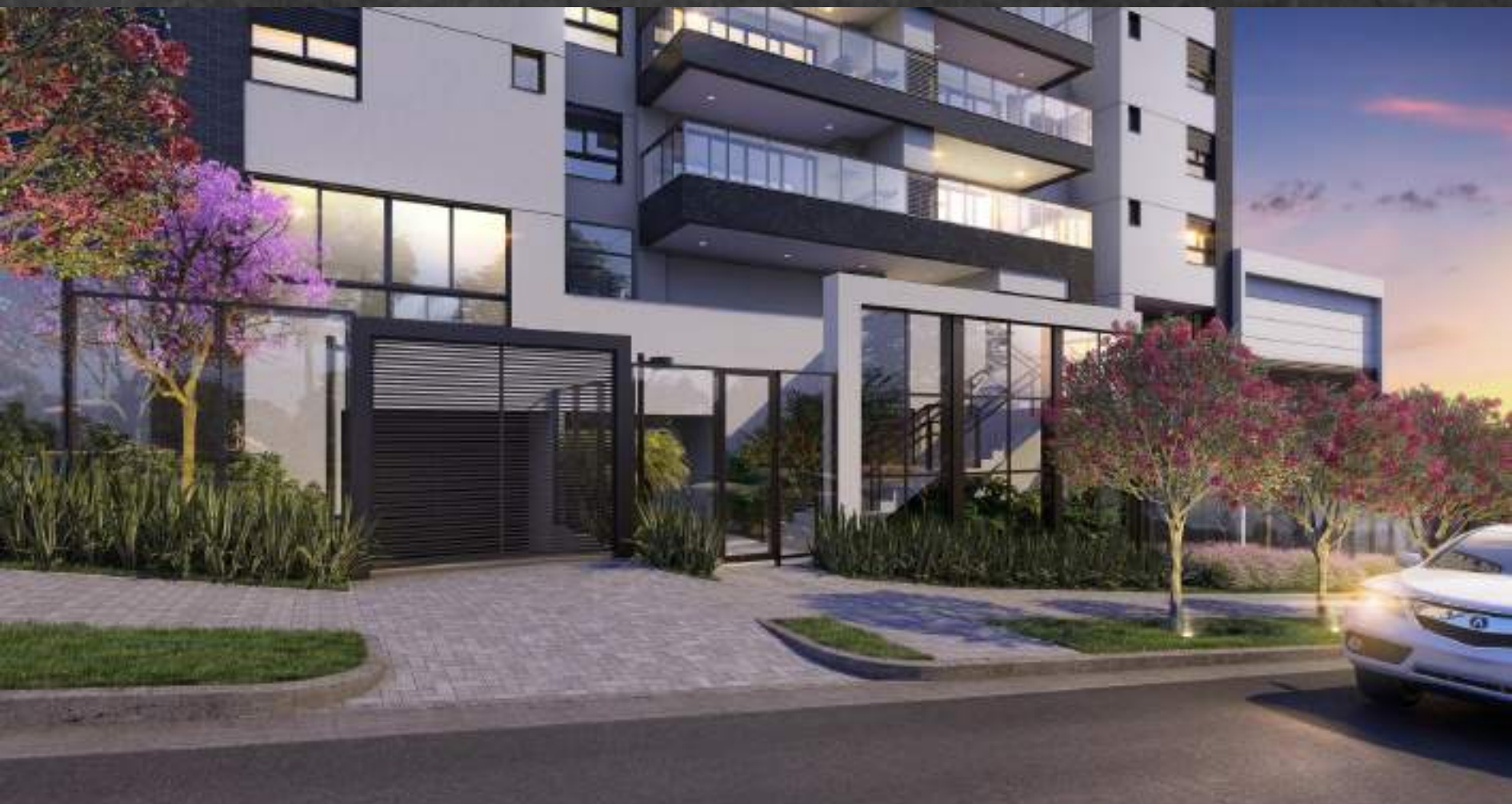
Portaria blindada e entrada de pedestres com clausura
